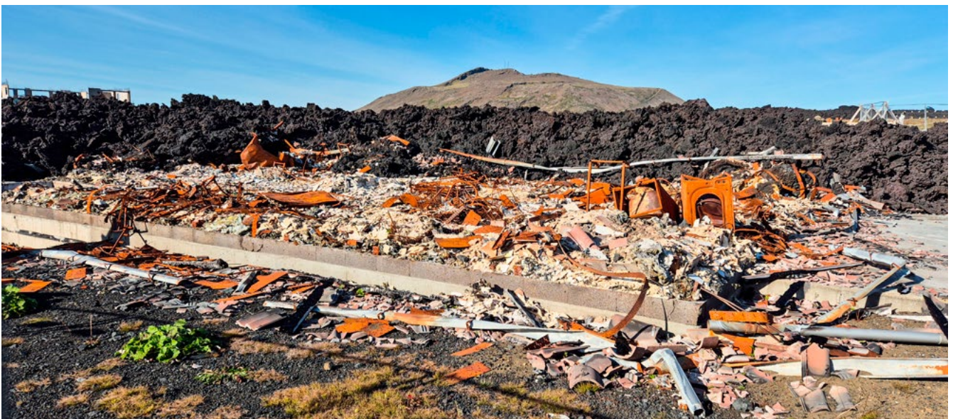
Mikil eyðilegging blasir við inni í Grindavík þar sem hraunstraumurinn náði að æða yfir nokkur hús áður en hann stöðvaðist.
