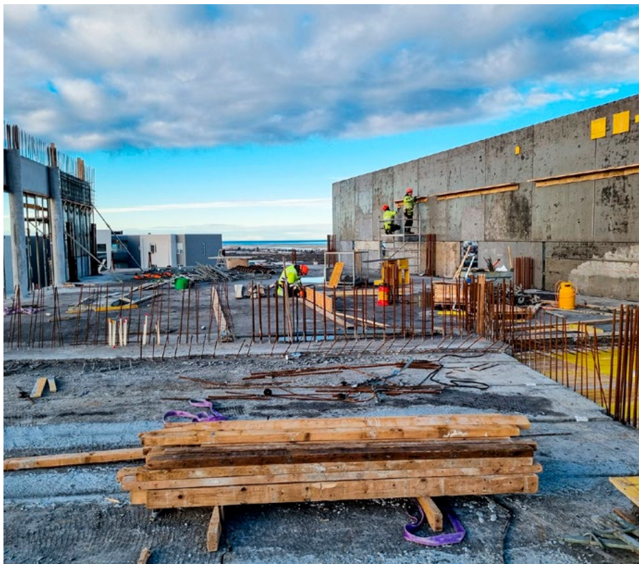
Framkvæmdir við Oddfellowhúsið í Urriðaholti hafa gengið mjög vel síðustu mánuði og farið að móta fyrir 1. hæðinni.
