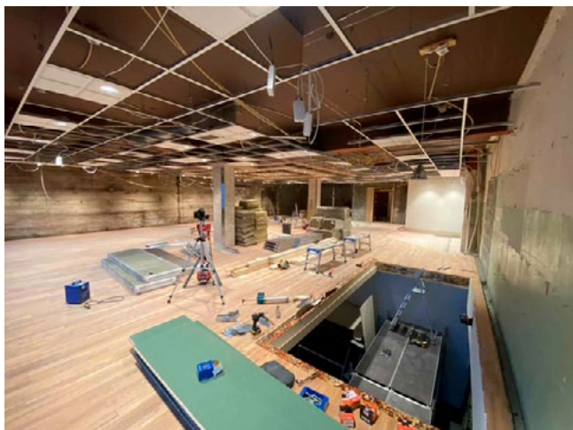
Verið er að taka húsið í gegn frá a-ö og m.a. byrjað að leggja nýtt gólfefni.
