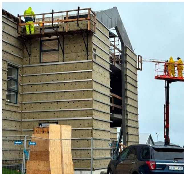
Framkvæmdir í gangi á húsinu utanverðu, en Herjólfsbær er á besta stað í miðbæ Vestmannaeyja.
